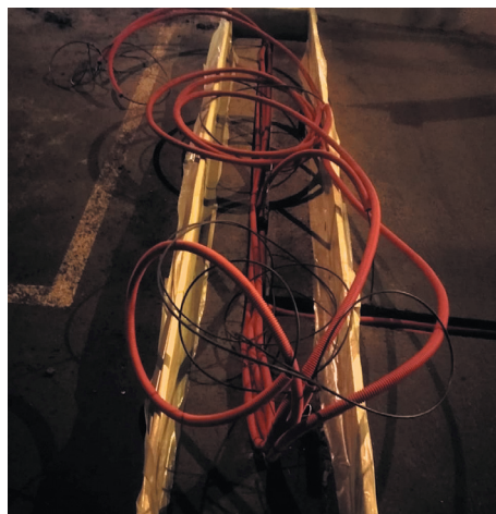
Рис. 8. Прокладка кабелей питания и связи при строительстве пункта пропуска
